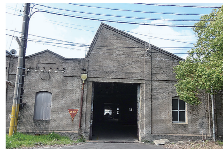
辰野金吾が設計したれんが造の八幡工場。1912(大正元)年に製釘工場として操業を始めた。100年以上が経過した今も、同社のものでつくりの拠点として稼働を続ける。建物は明治期に活躍した建築家の辰野金吾(1854~1919年)が設計。東京駅をはじめ数々の有名建築を手掛けた「日本近代建築の父」による現役の工場を見学に来る人も少なくない。
